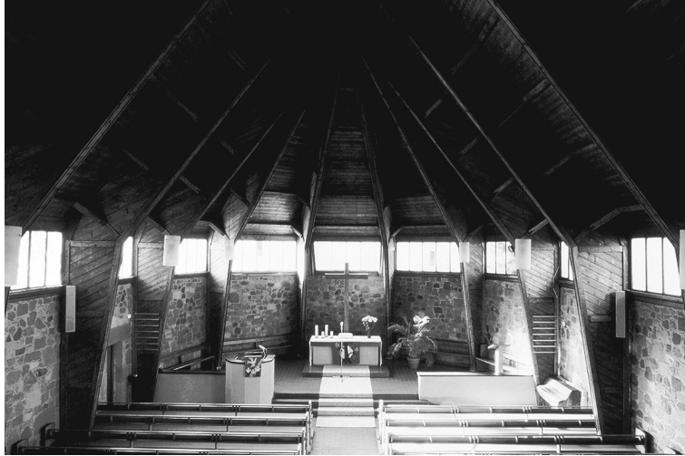
Abb. 1: Gießen, Pankratiuskapelle (Bartning-Notkirche), tragende Konstruktion aus Holzbindern, die Wände sind aus Trümmersteinen ausgemauert (1948–49).
